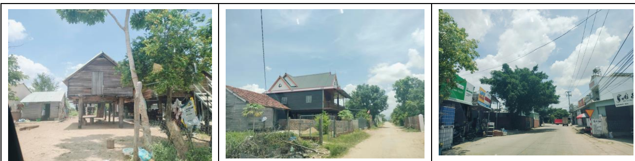
Hiện trạng nhà ở dân cư trên địa bàn xã
